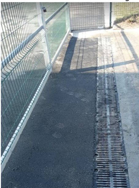
Instal·lació de reixa de drenatge
